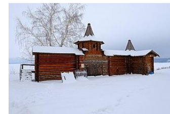
Реконструкция стены Осинской крепости
